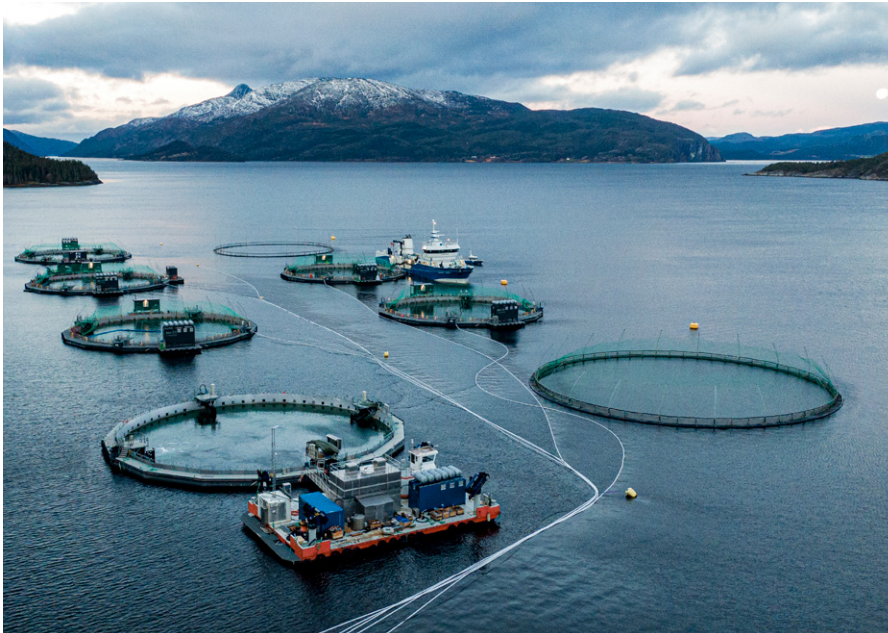
Mulingen i Bindal består av seks lukkede merder; noe som gjør lokaliteten til landets eneste med kun denne løsningen.
