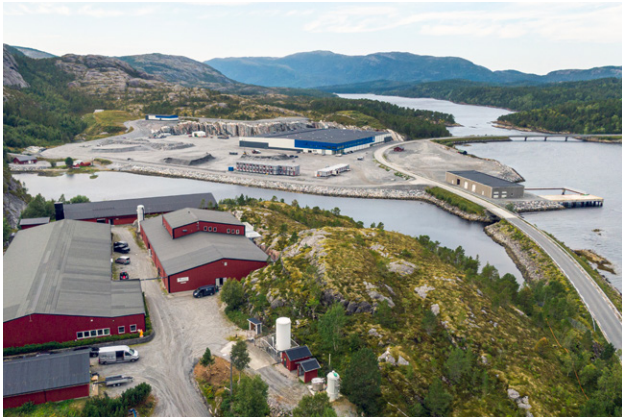
Dagens to anlegg ved Svaberget; nærmest avdeling Saglifossen (gjennomstrømning) og bak nye avdeling Svaberget (RAS).
