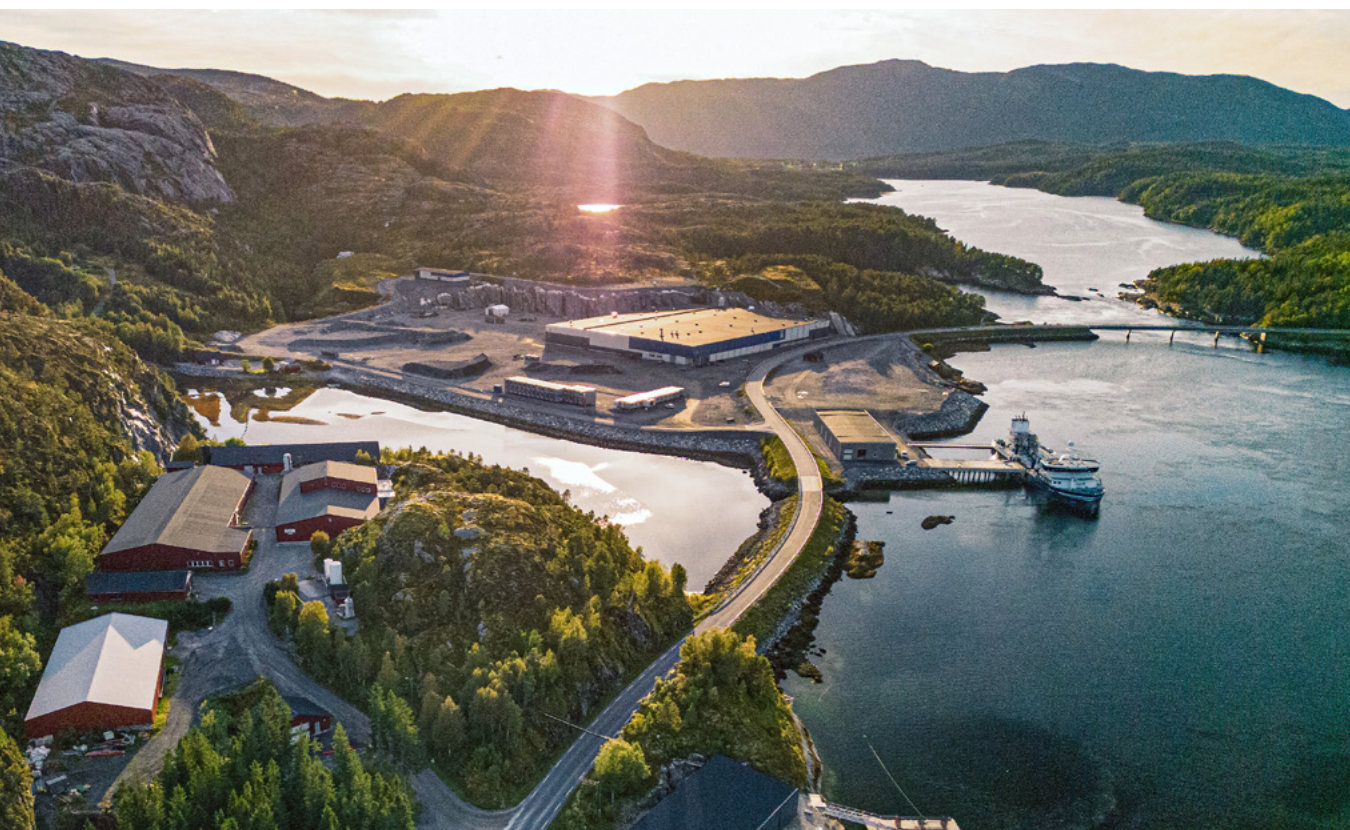
PÅ FYLKESGRENSA: Til venstre ser man avdeling Saglifossen i Bindal Kommune / Nordland Fylke og til høyre avdeling Saglifossen i Nærøysund Kommune / Trøndelag Fylke.
